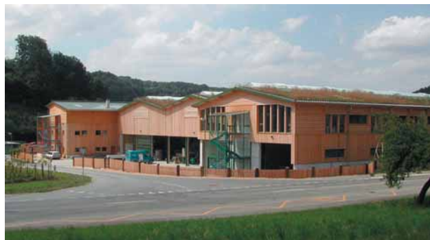
Das vom LBA realisierte Energieholzzentrum Nordwestschweiz mit einem Gesamtbauvolumen 31 500 m 3 . Es wurde Lothar-Holz für Konstruktion, Decken, Dach, Fassaden und Innenausbau verwendet. Die begrünte Dachkonstruktion dient als Wärmeschutz und Regenwasserrückhalt. Das Gebäude wird mit einer Holzschnitzelheizung beheizt.
